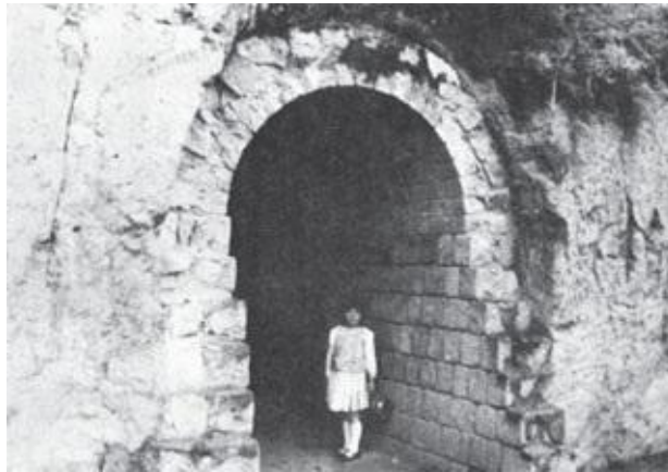
Fig. 10.4. La Olla. Entrada externa do túnel. As pedras da fachada foram removidas.
