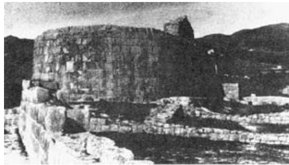
Fig. 4.4. Inca Pirca no Equador. As paredes são construídas com o mesmo cimento de ferro encontrado na parede de Cuenca.
